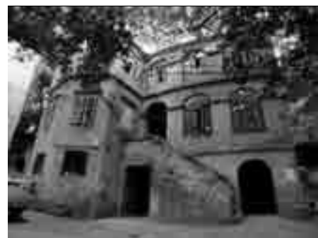
材料三 槐荫里 4 号福州中共地下电台旧址
